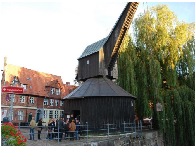
Abb. 1 Alter Kran im ehemaligen Ilmenau-Hafen in Lüneburg
